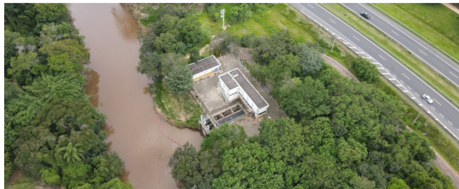
Nova linha de adução de água bruta do Rio Atibaia Captação de mais 90 litros por segundo
